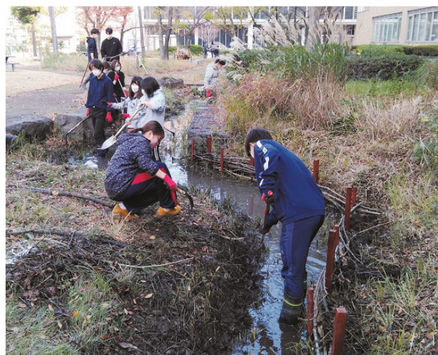
連柴柵工による多自然型護岸整備の様子
