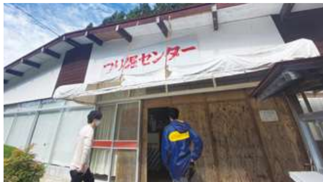
入水鍾乳洞駐車場にある、かつて賑わっていた釣り堀センターの視察
