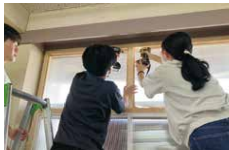
インパクトドライバーで教室に内窓を設置する学生スタッフ
